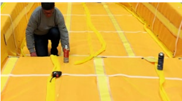
Verlegen von G-LINE, Fließkanal und Entlüftungsband G-filter
